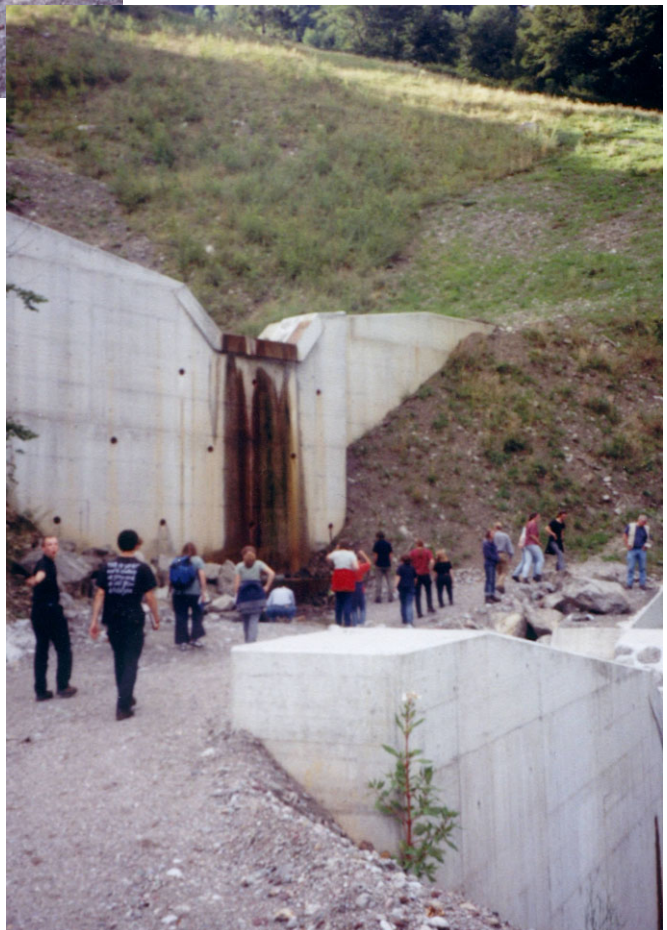
Abb. 12 Wildbachverbauung im Bereich des schlimmsten Murenabgangs
